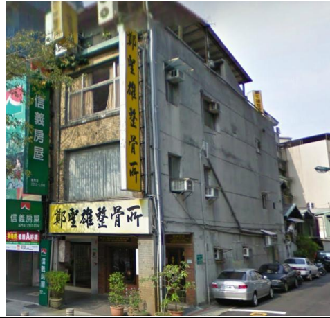
背(側)向立面照片
