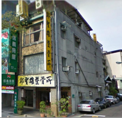
背（側）向立面照片
