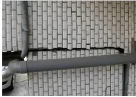
外牆柱斷裂
